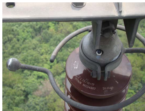
图 2 A 相绝缘子招弧角放电痕迹
