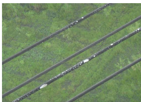
图 1 A 相导线放电痕迹照片
